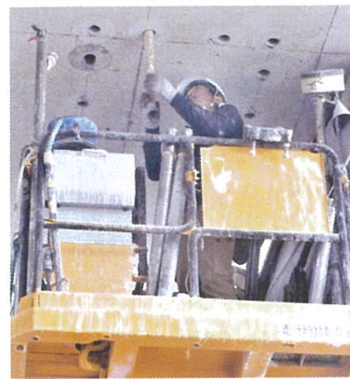
支承補完構造設置のためのアンカーボルト用削孔
