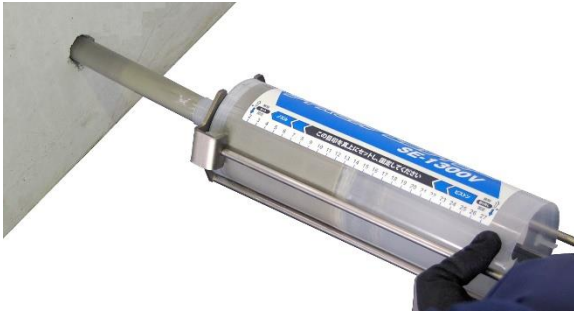
コンクリート孔内へ注入
