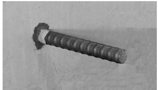
孔内へ注入後、アンカー筋の施工
