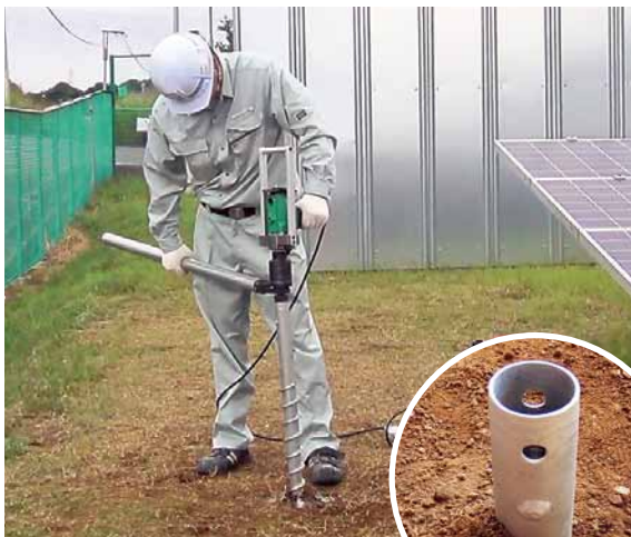
スクリー施工
