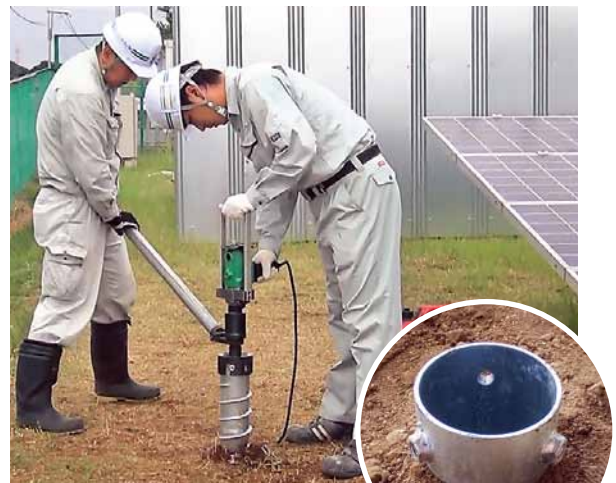
スクリー施工
