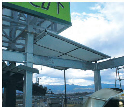
角形鋼管への テントユニットの取付け
