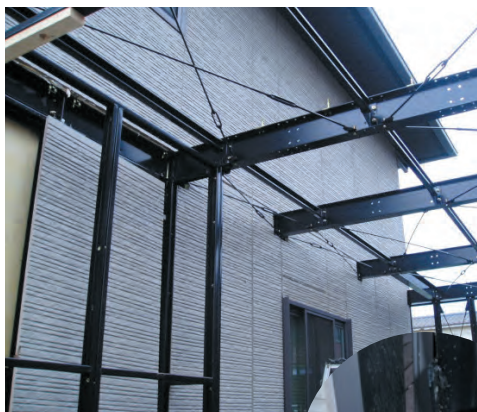
住宅の増築時の梁の接合
