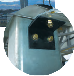
角形鋼管への テントユニットの取付け
