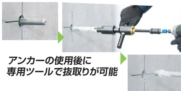
アンカーの使用後に専用ツールで抜取りが可能
