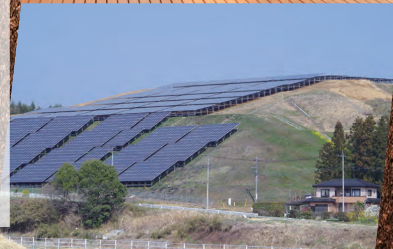
施工イメージ
