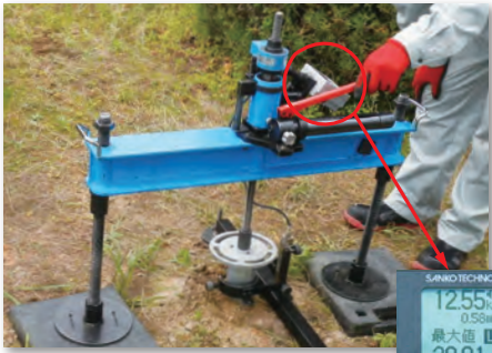
引抜き試験状況
