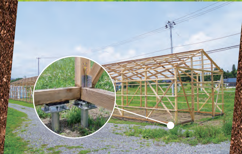
施工イメージ
