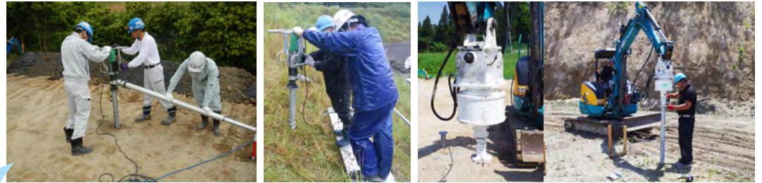
ハンド型電動回転工具施工（平地・法面）
