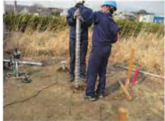
写真 2.4 試験体設置状況
