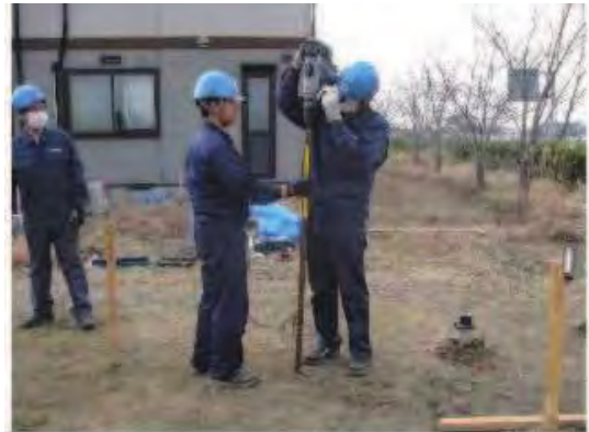
写真 2.2 プレボーリング状況
