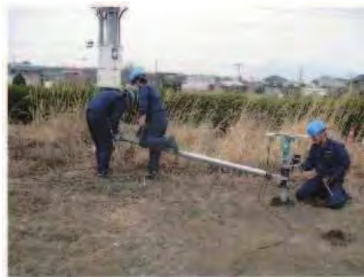
写真 2.6 打ち止め完了状況
