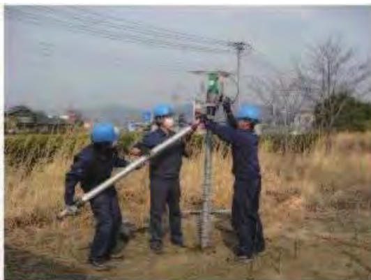
写真 2.5 施工機材設置状況
