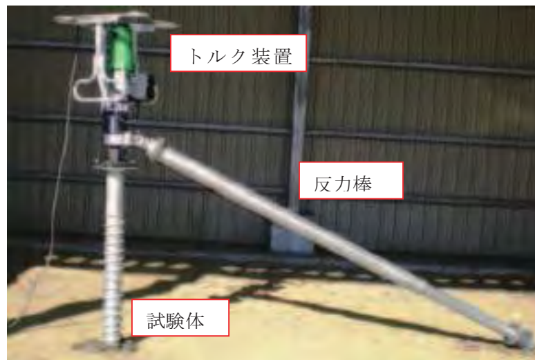
写真 2.1 施工機材設置状況
