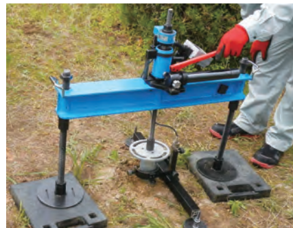
小型試験機による引抜き試験実施状況
