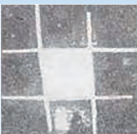
【角形】 補修範囲が井桁状
