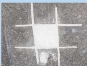
【角形】補修範囲が井桁状
