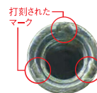
施工後アンカー面 (施工完了マーク付ホルダーで完全施工した場合)
