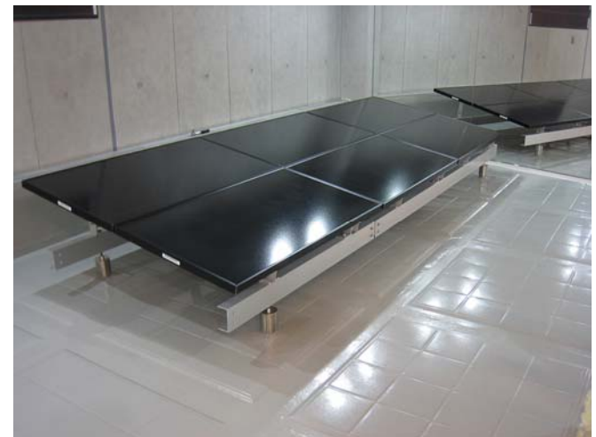
あと基礎アンカー施工例
