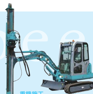
重機施工 大量施工には専用重機での対応も可能
