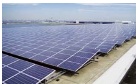
神奈川県(あと基礎アンカー)
