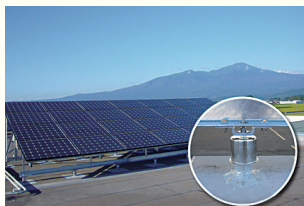
太陽光パネルの架台取付けに
