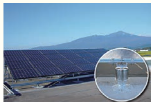
太陽光パネルの架台取付けに
