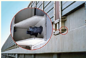
高速道路の防音壁の取付けに
