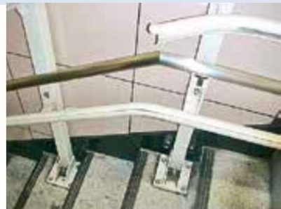
階段手摺り取付け
