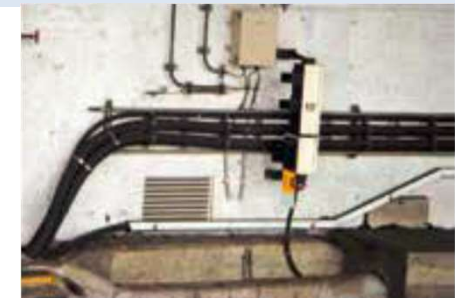
ケーブルラック取付け
