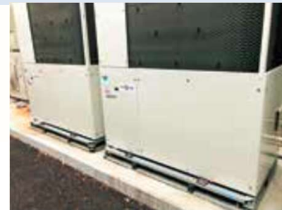
室外機取付け
