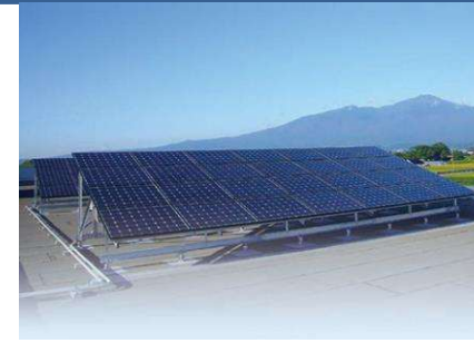
太陽光発電システム設置
