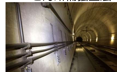
不感知対策工事
