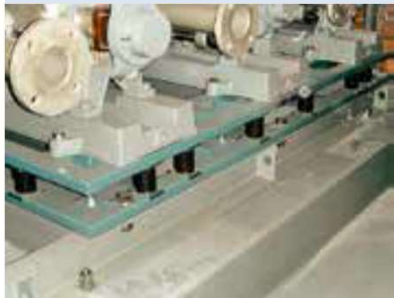
揚水ポンプ基礎
