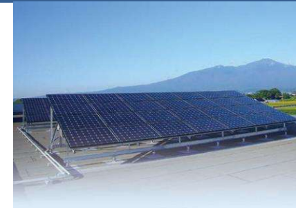
太陽光発電システム設置
