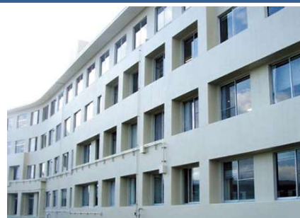
耐震補強工事
