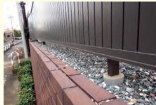
フェンスの取付けに
