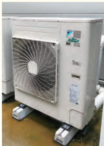
室外機の取付けに
