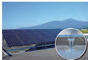
太陽光パネルの架台取付けに
