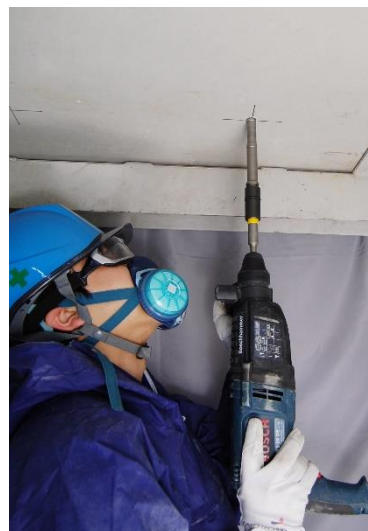
▲製品の施工風景
