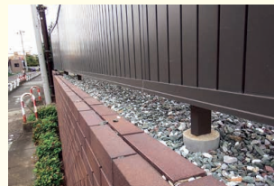
フェンスの取付けに
