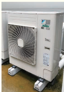
室外機の取付けに
