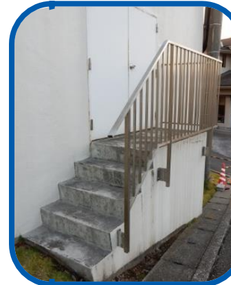
手すりの取付けに・・
