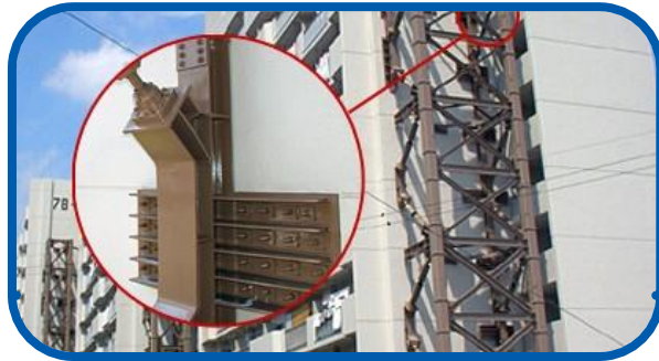
建物の耐震補強に・・
