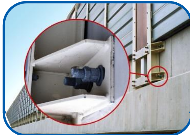
高速道路の防音壁に・・
