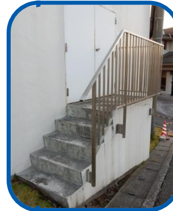
手すりの取付けに・・
