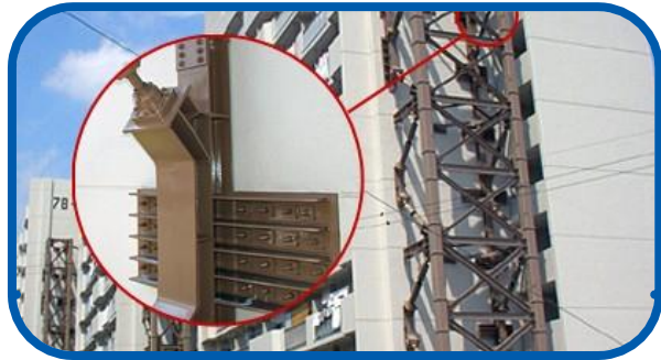
建物の耐震補強に・・
