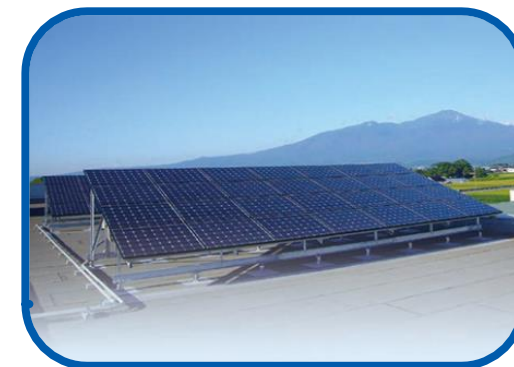
ソーラーパネルの設置に・・
