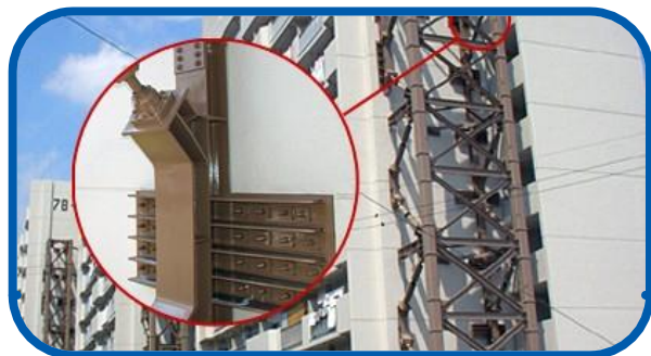
建物の耐震補強に・・
