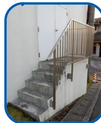
手すりの取付けに・・
